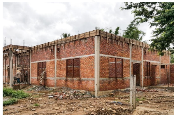
Bau der neuen pädiatrischen Station in Muang Kham
